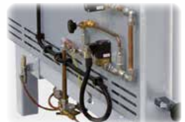
Gasstrækning og termoelement på kammerovnovn
